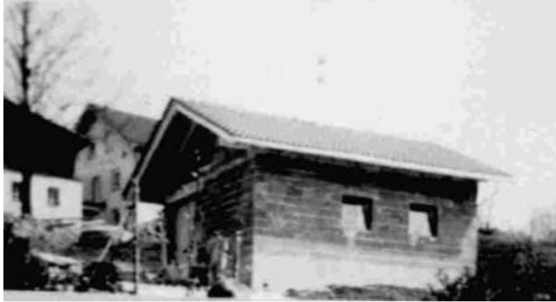
Das neue Feuerhaus im Rohbau
